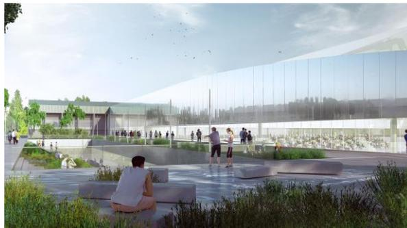
La majorité de la façade sera constituée d'un bardage en finition d'aluminium poli. Un bandeau vitré de 2,40m de haut en simple vitrage droit et courbe ceinturera l'ensemble du bâtiment.
